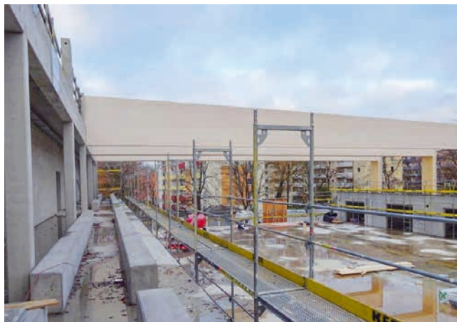
Der Baufortschritt der neuen Dreifach-Schulsporthalle ist deutlich sichtbar.
