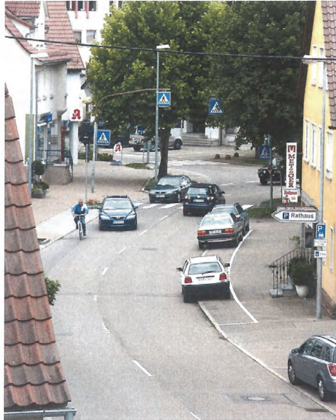
Bilder 8 und 9: Umbau Backnanger Straße (vorher/nachher)
