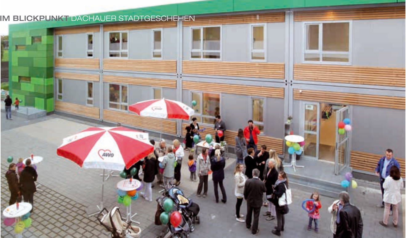
Erweiterung Kinderhaus Augustenfeld, die Erste: Im neuen Nebengebäude werden Kleinkinder betreut.
