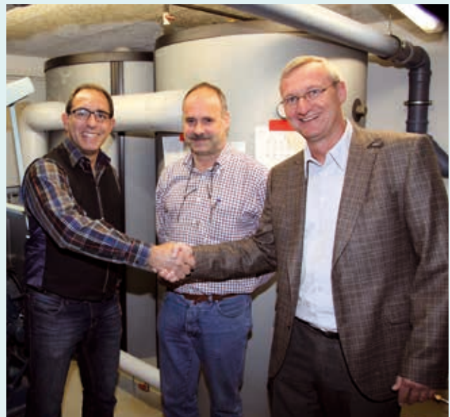
Zufriedene Gesichter bei der Inbetriebnahme (v.l.): Thomas Foh (Stadtwerke Dachau), Henriko Müller (Heizungsfirma Wittmann HTA) und Hendrik Röttgermann (Geschäftsführer Stadtbau GmbH Dachau).
